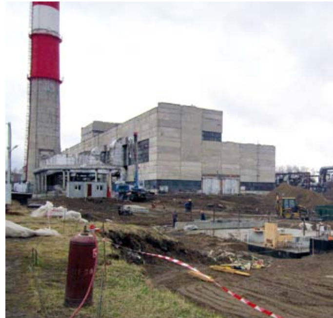
ГТУ-16 МВт. Подготовительный период
