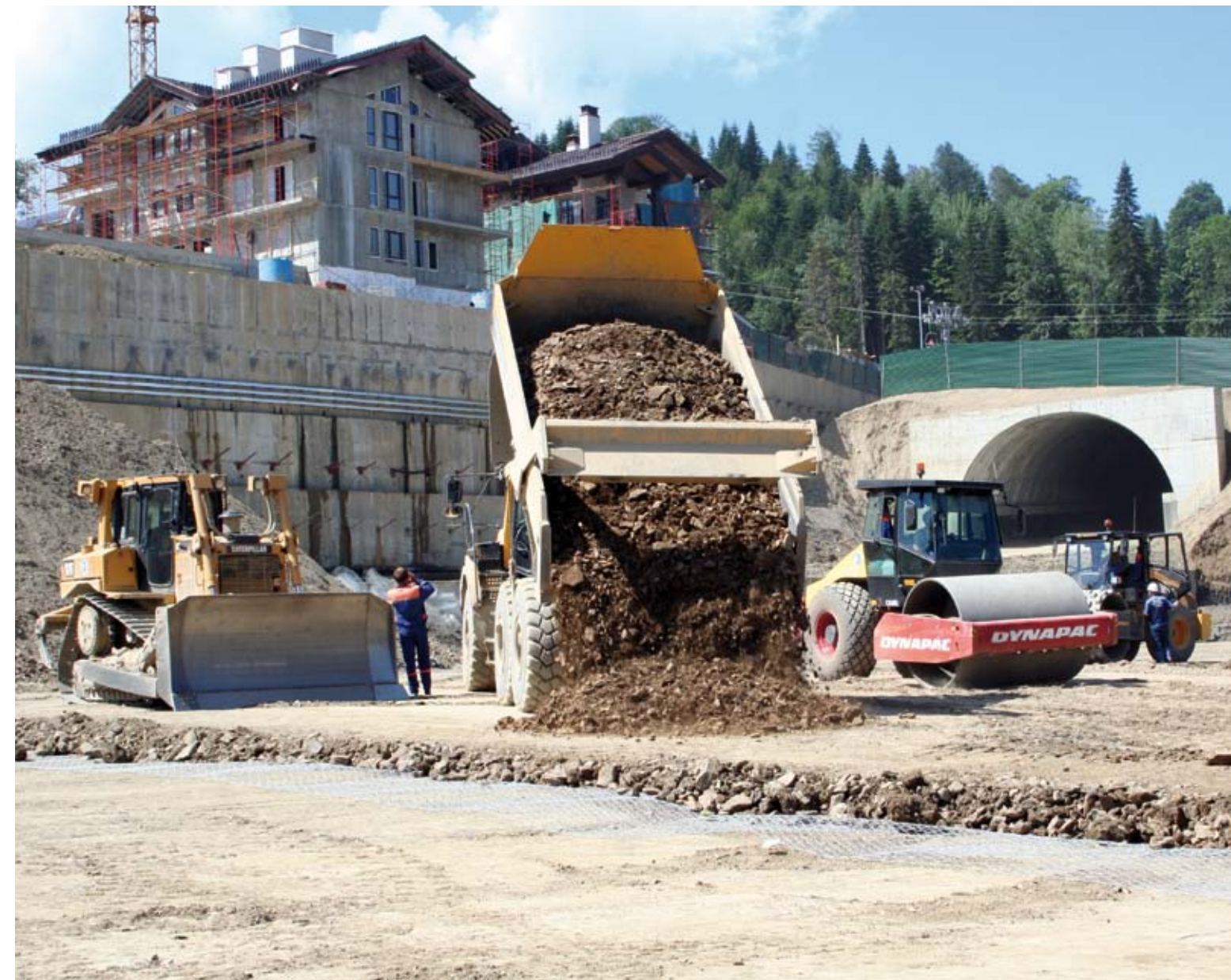
Строительство автомобильной дороги и тоннелей
