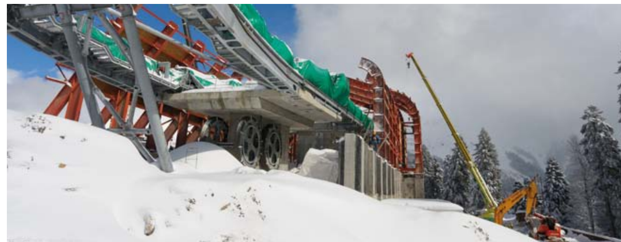
Строительство станции канатных дорог 3S на площадке Пихтовая поляна
