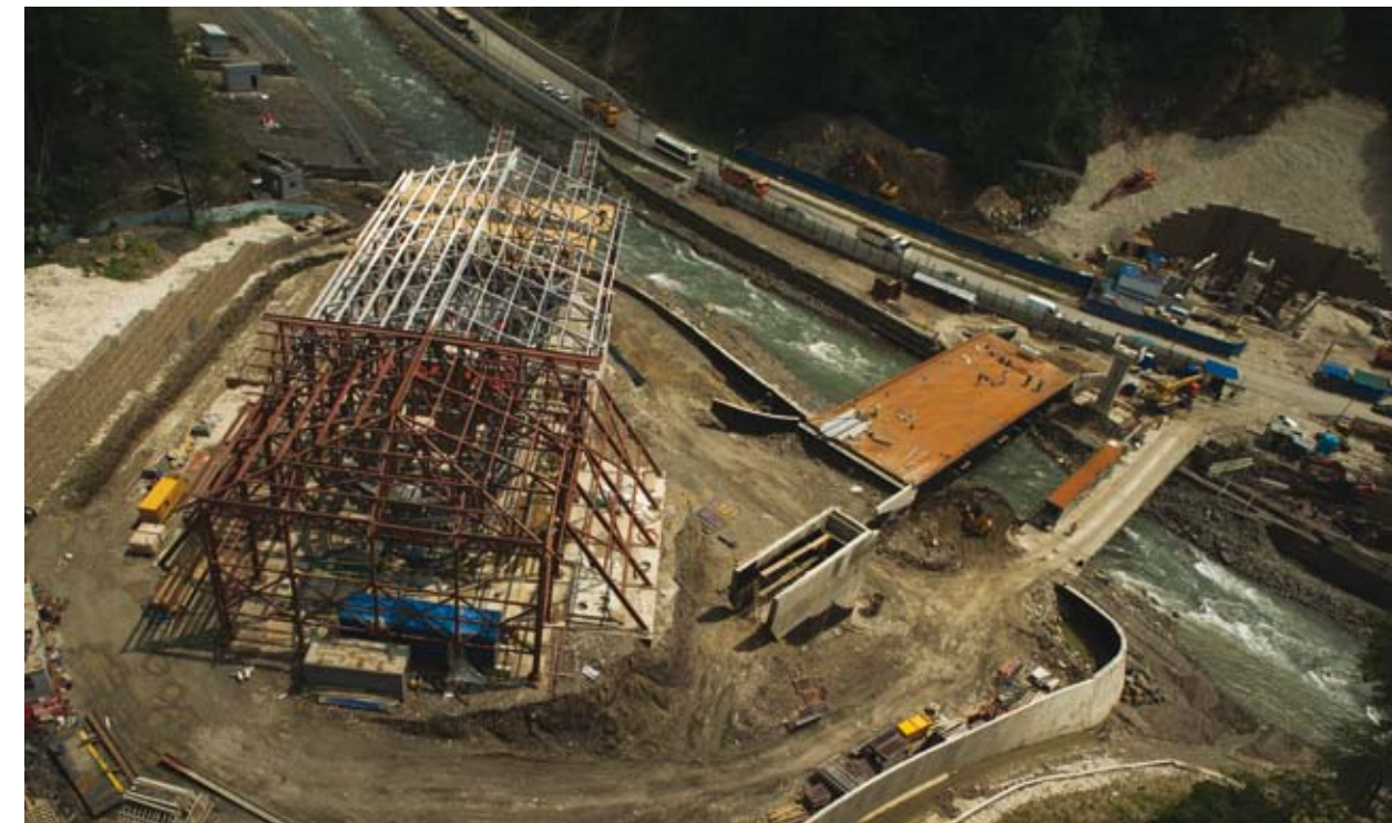
Строительная площадка нижней станции канатной дороги 3S
