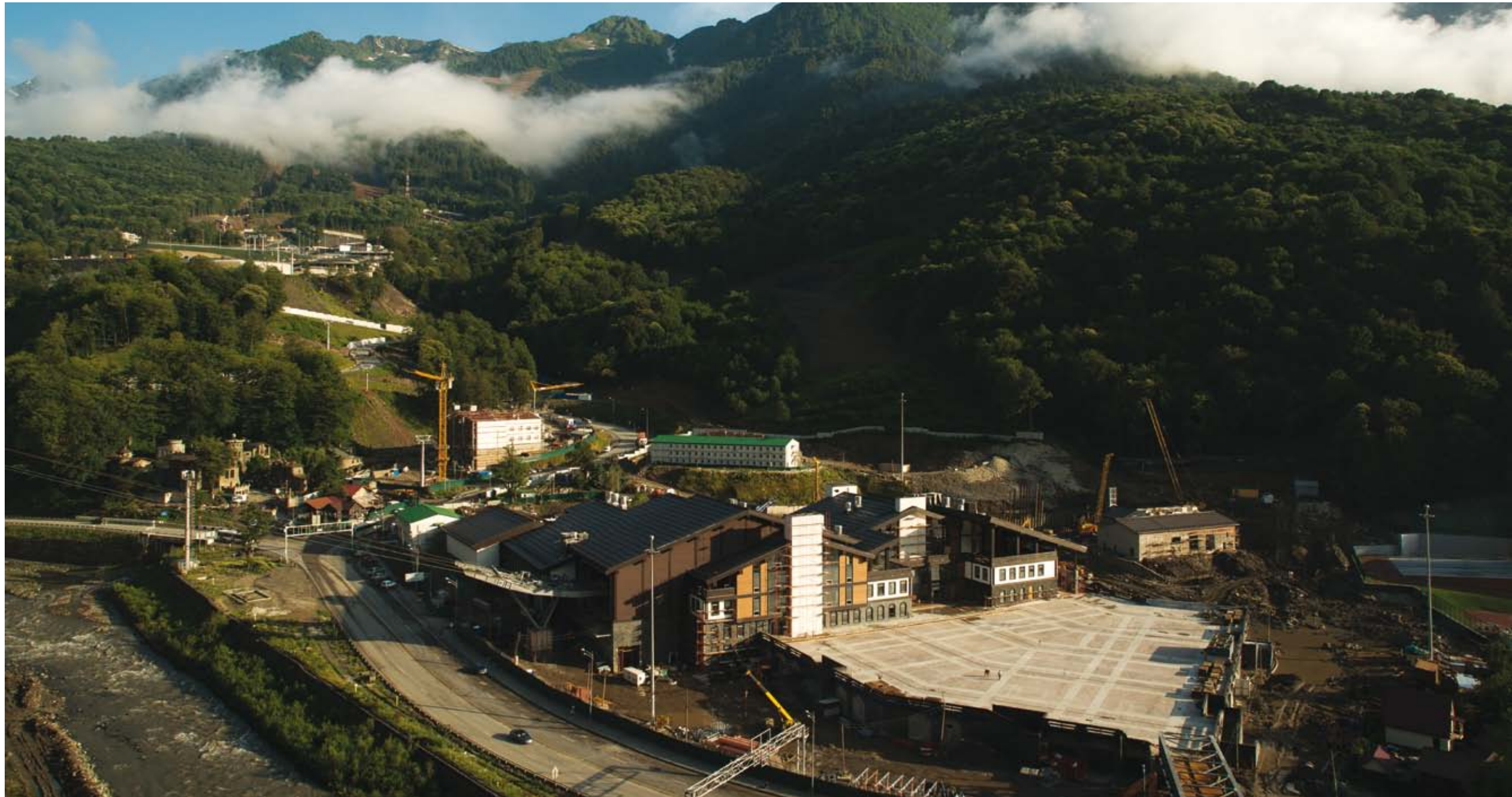
Площадка строительства ГКК «Альпика-Сервис», пос. Красная Поляна
