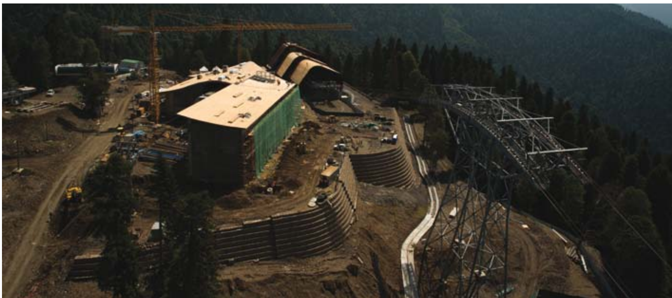
Строительство станции канатных дорог 3S Псехако II А-3
