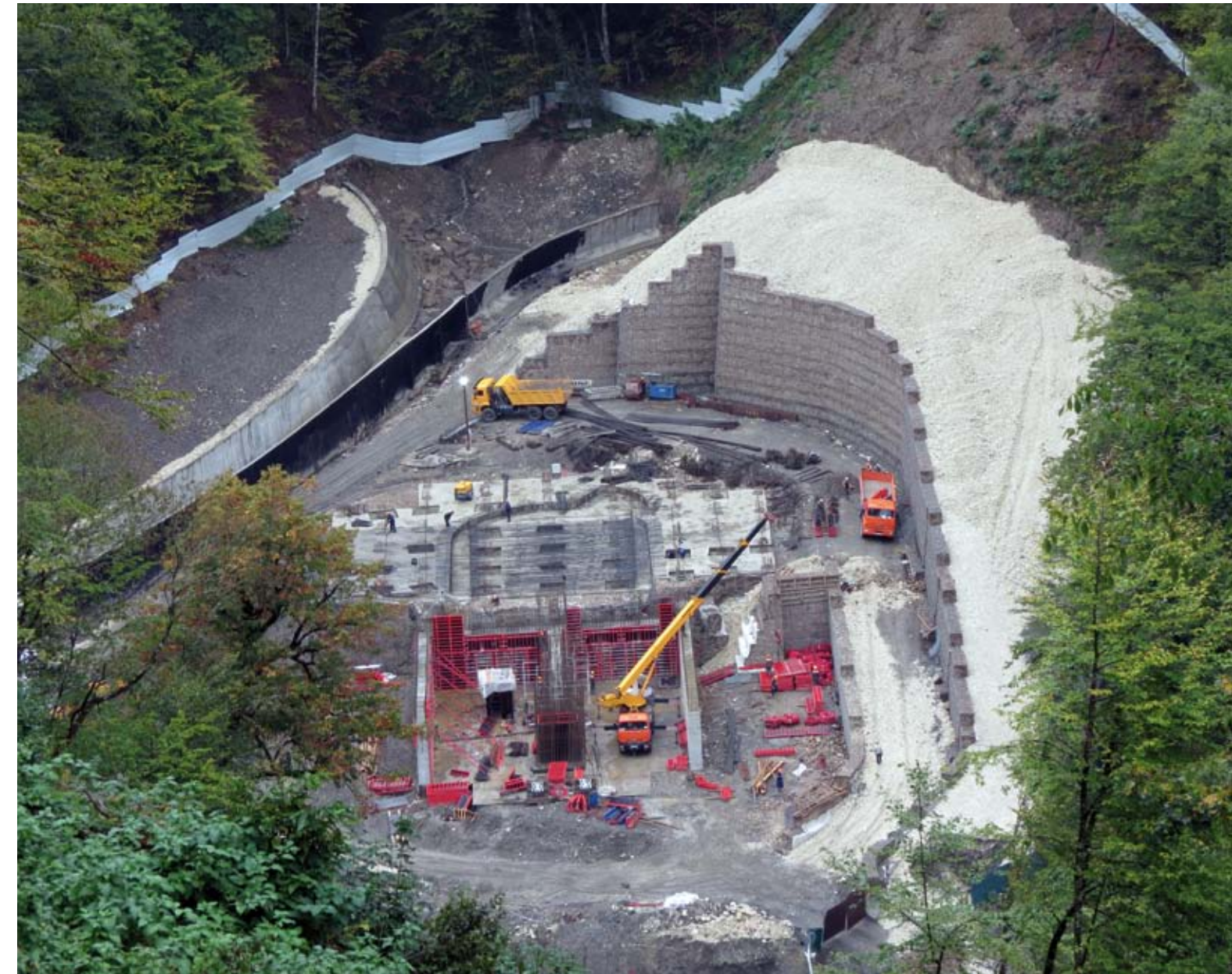
Строительство фундамента на уклонах
