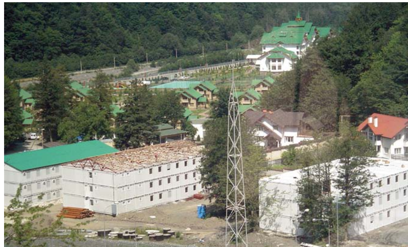
Возведение штаба строительства
