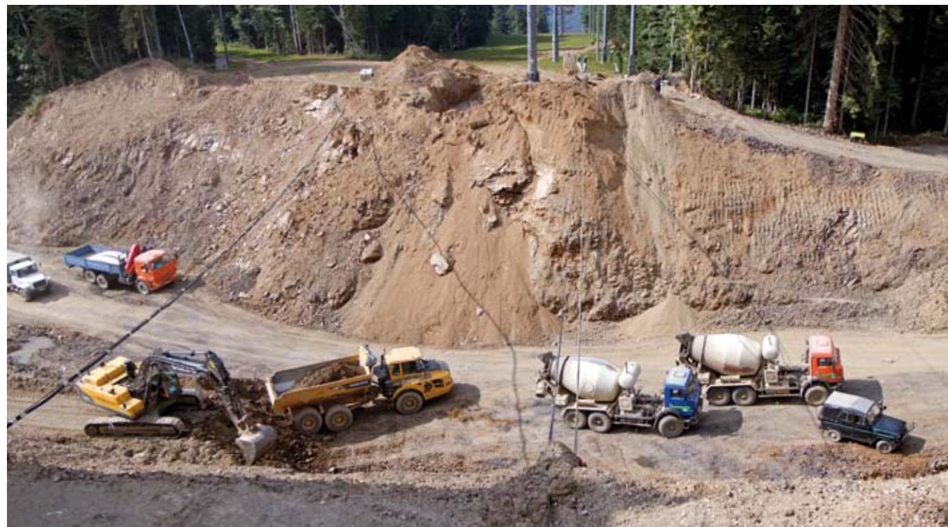
Строительство автомобильной дороги
