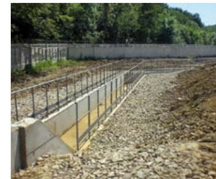
Площадка строительства ТЭС, а не ГТУ-16
