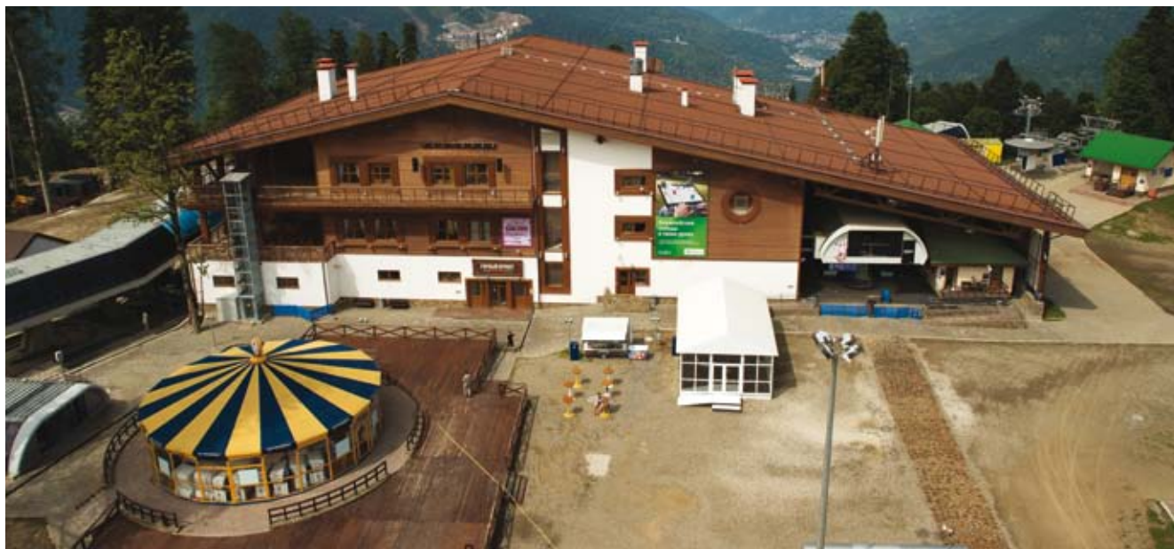
Здание «Горного приюта»
