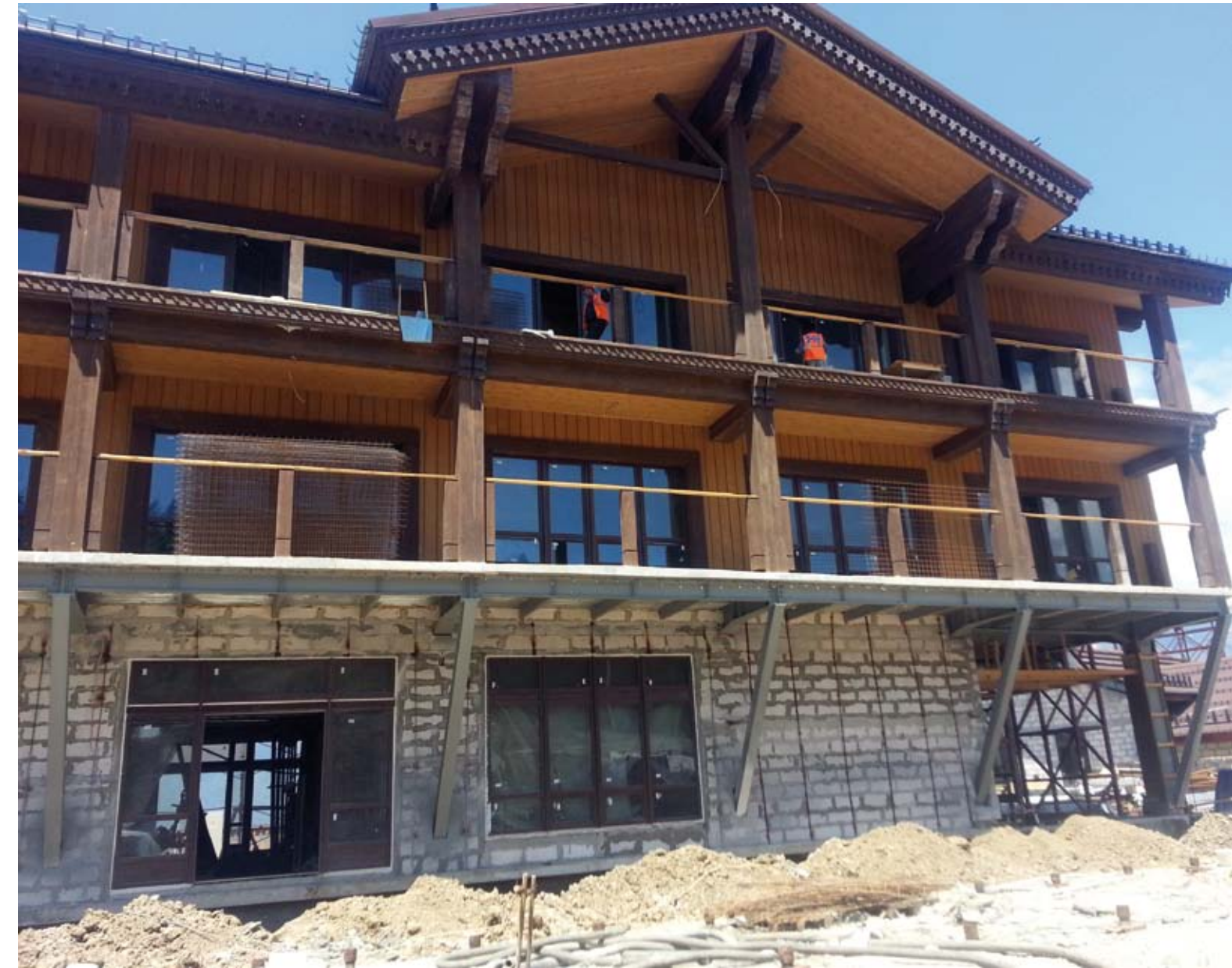
Площадка строительства гостиничного комплекса ГТЦ ОАО «Газпром», пос. Красная Поляна
