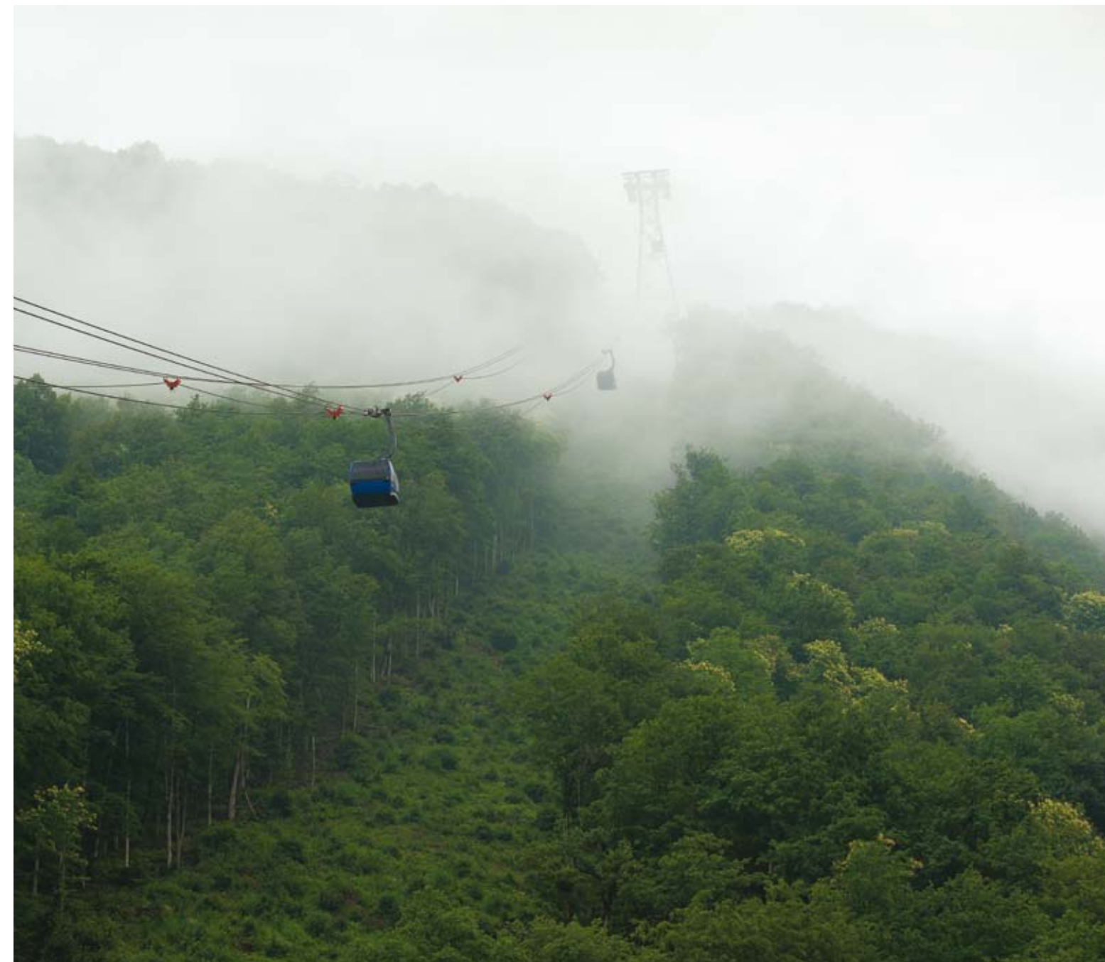
Пуско-наладочные работы новой канатной дороги
