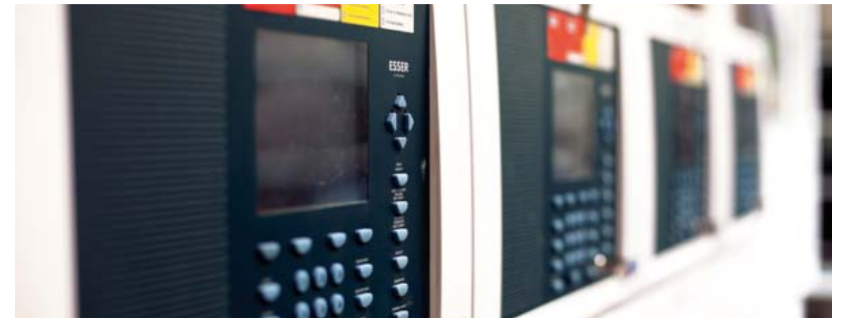
Помещение операторской службы
