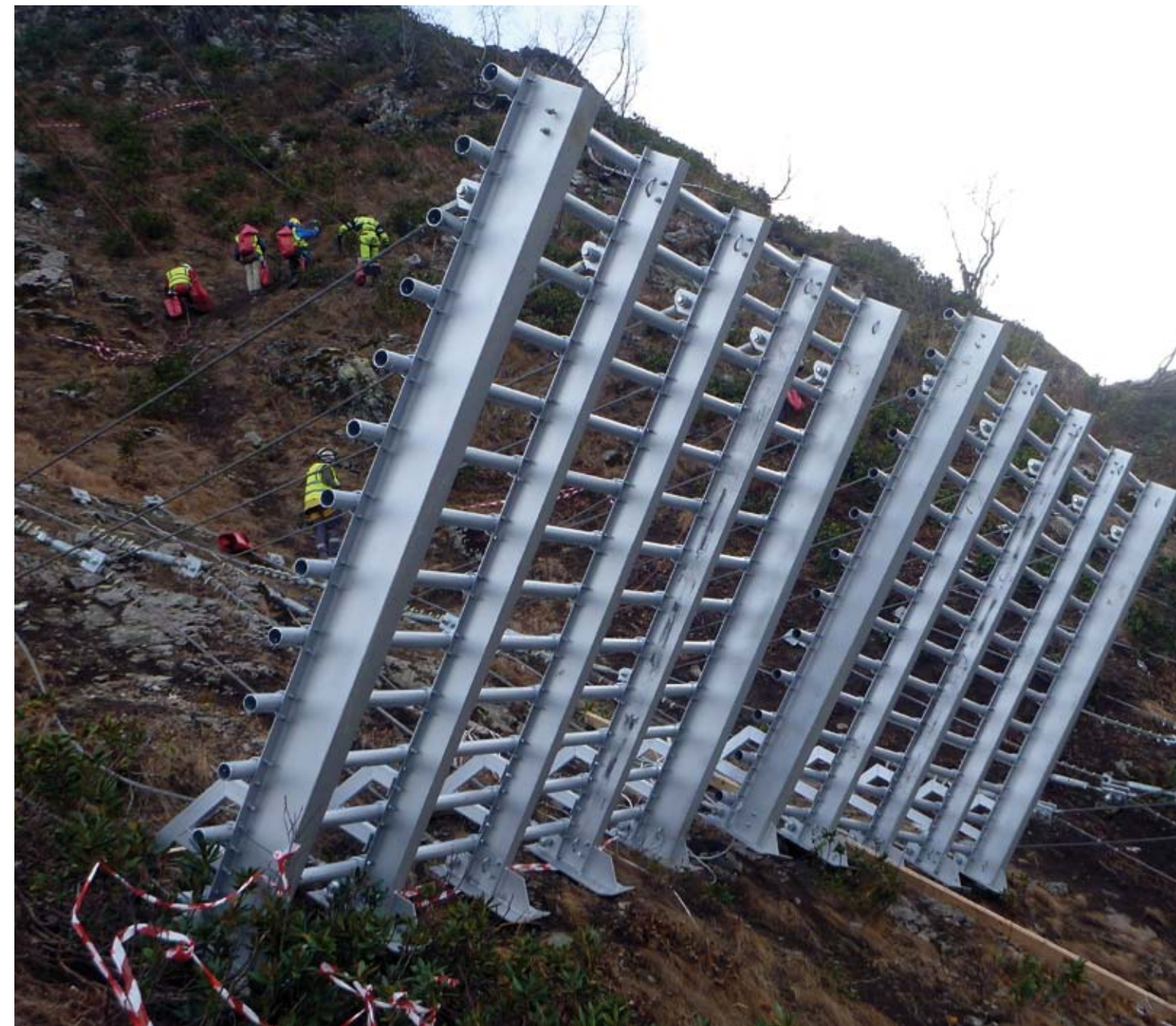
Монтаж лавинозащитных барьеров
