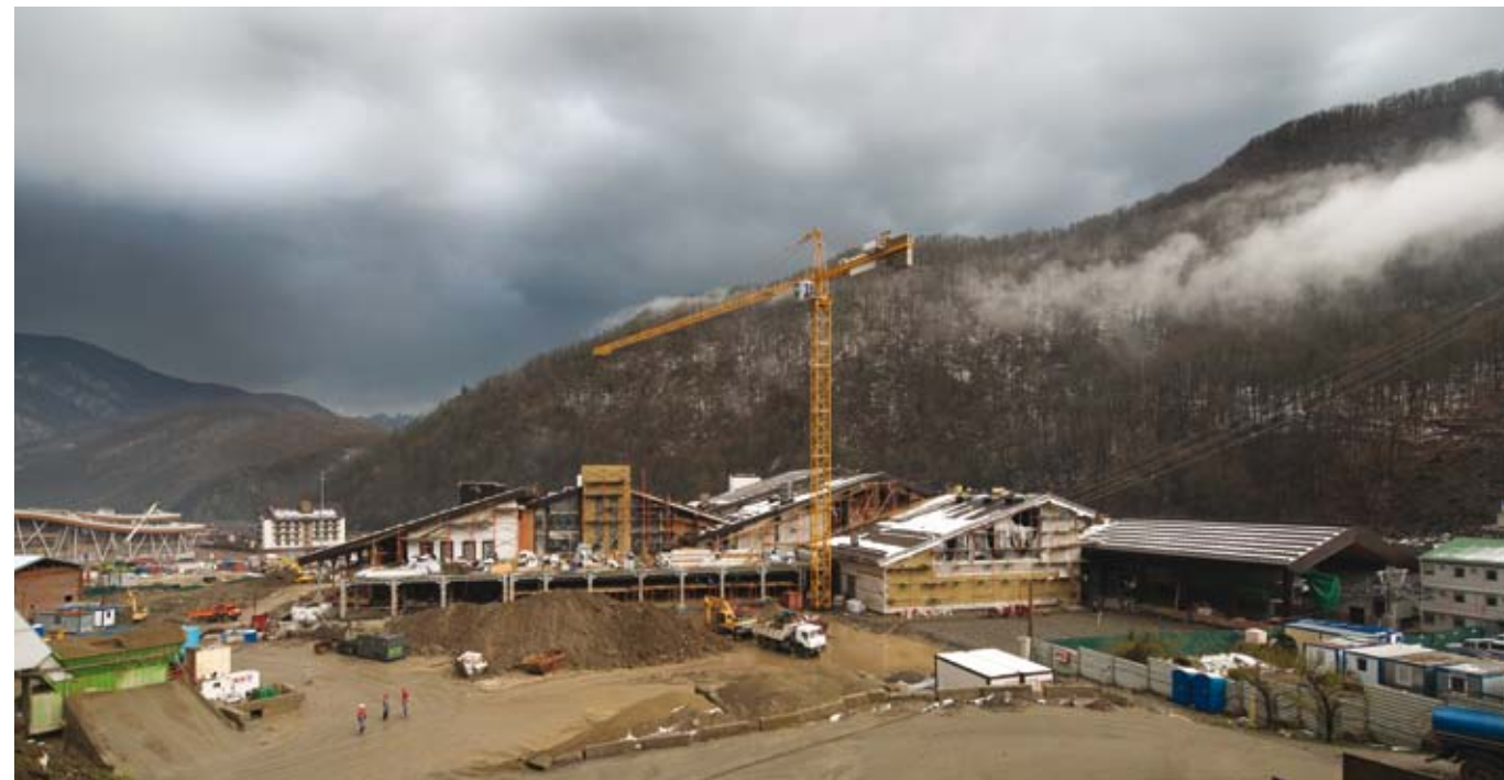
Строительная площадка ГКК «Альпика-Сервис», пос. Красная Поляна
