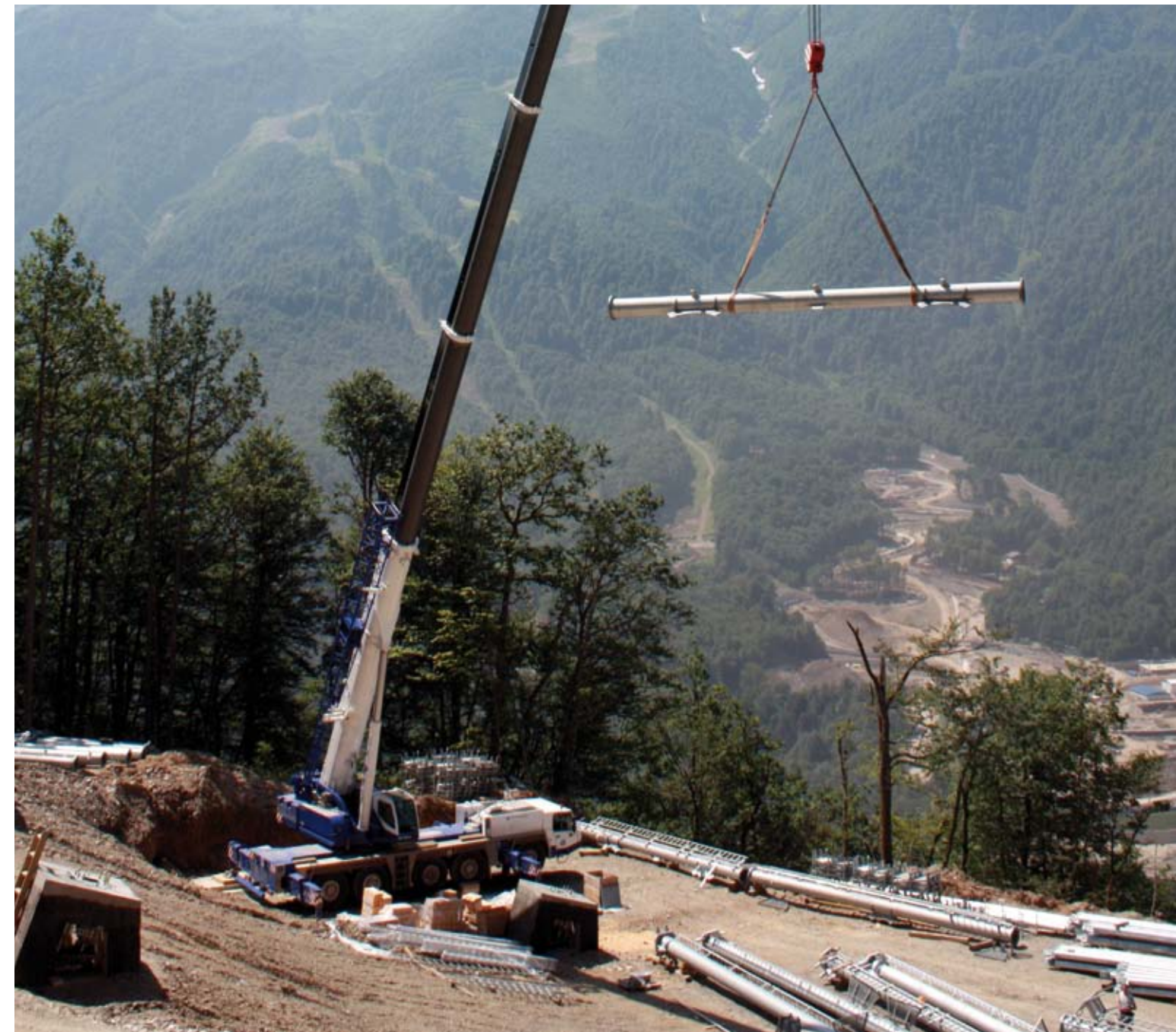
Монтаж опор канатных дорог
