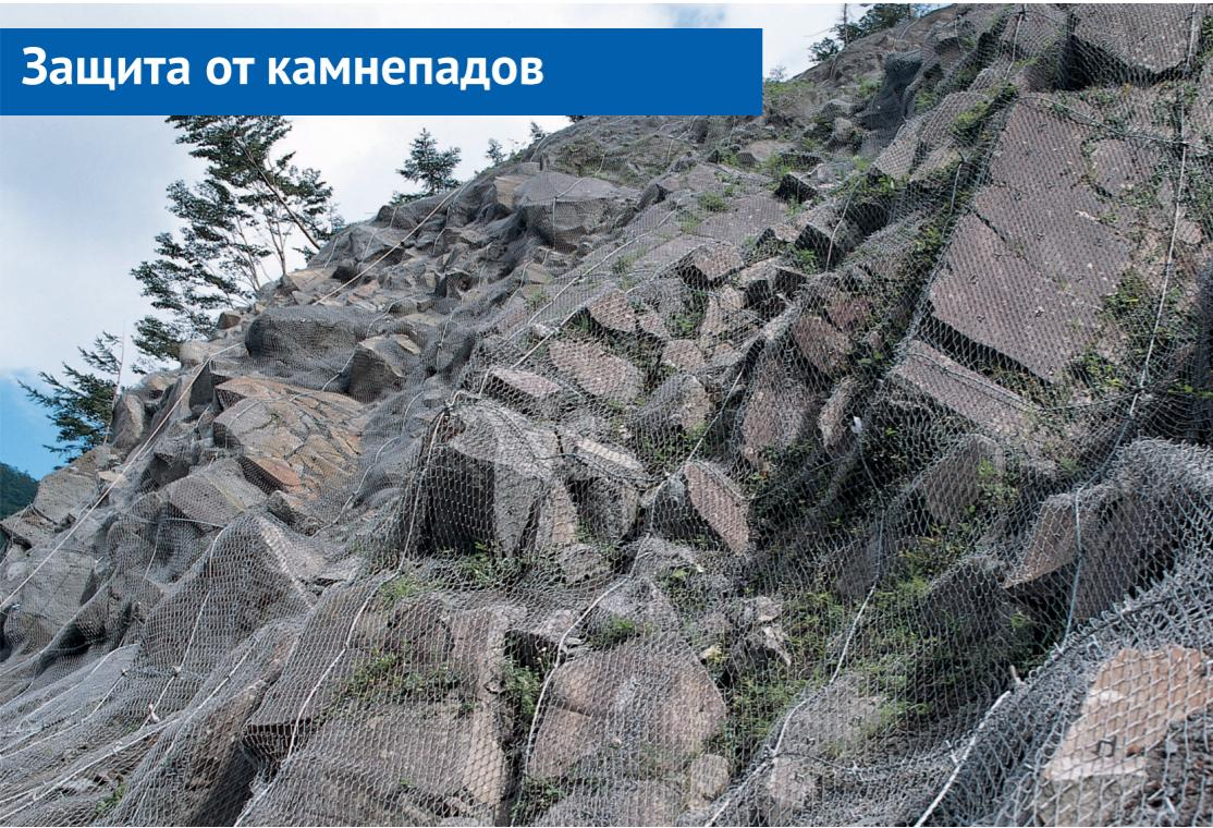
Защита от камнепадов заключается в возведение специальных сооружений направленных на предотвращение падения или скользования больших каменных масс.
